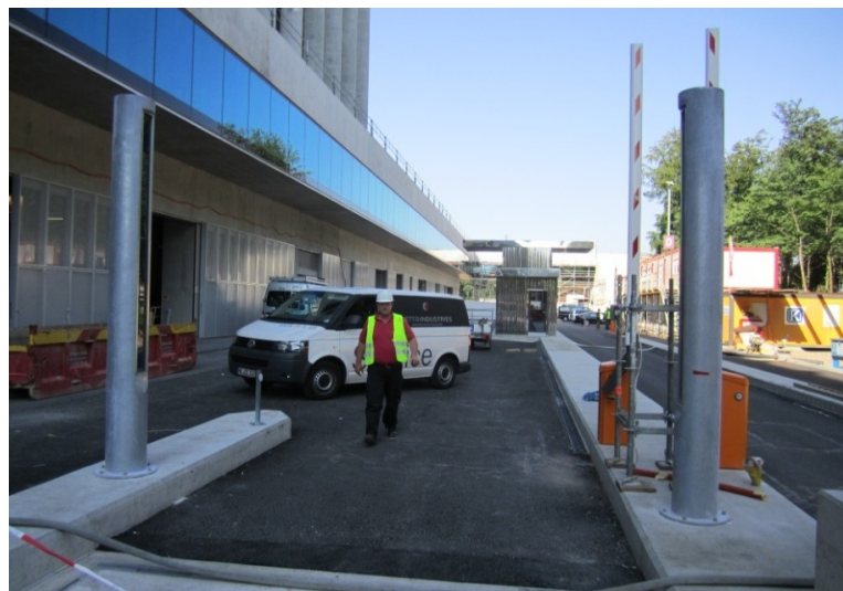
La balance pour les camions étant parallèle à la route de passage et sans séparation évidente, les colonnes nécessitaient une protection solide. Aussi, pour une meilleure visibilité lors de conditions de vue restreinte des bandes LED sont montés le long des colonnes. Lors de cette installation, les installations à 32-canaux existantes sont mis à jour avec des nouveaux ordinateurs permettant l'utilisation des logiciels actuels avec 1024-canaux, donnant la possibilité d'identification des nuclides.
